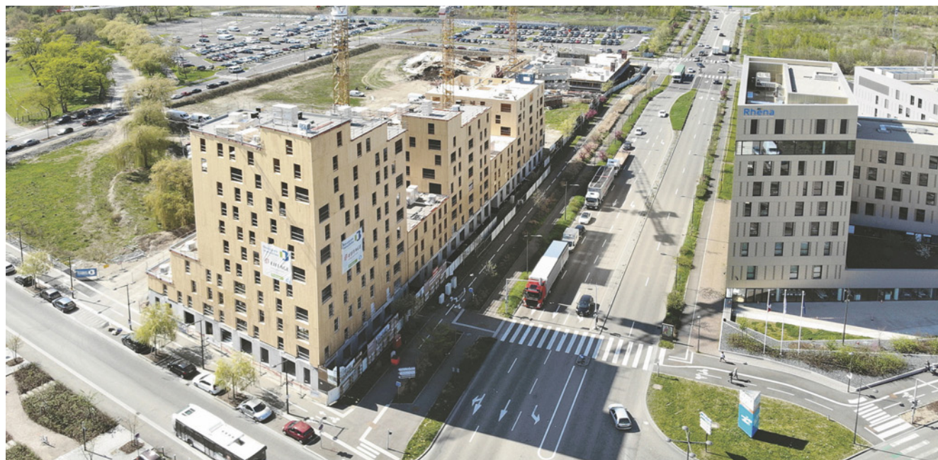
Sensations, un immeuble d'habitation en bois de 38 mètres de haut sur 11 niveaux, doit être livré cet été par Bouygues Immobilier à Strasbourg.
